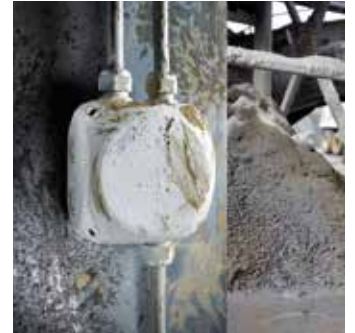
KF-Serie: IP 66 / IP 67 / IP 69 wetterfest, für die ungeschützte Installation im Freien metrische Vorprägungen
